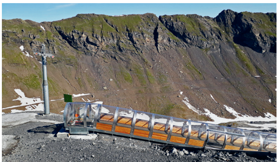
Das Streitobjekt Förderbandtunnel.
