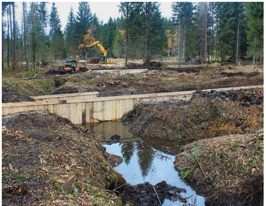
Travaux en cours dans le marais des Pontins: construction de digues au travers d'un fossé de drainage (photo du 18.10.2015 / Pro Natura, Bastien Amez-Droz)
