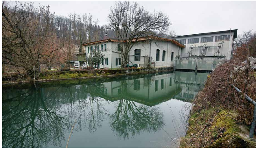
Canal supérieur et centrale électrique dans la région d'Altisberg. Photo: J. Ryser
