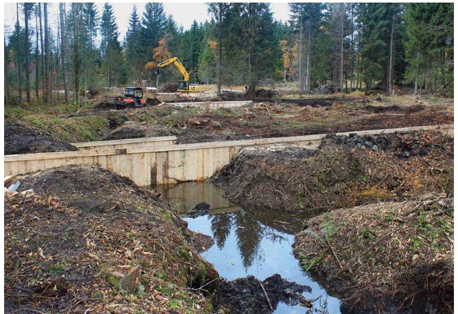
Renaturierungsarbeiten im Moor von Les Pontins: Bau von Sperren in Gräben. Foto: 18.10.2015, B. Amez-Droz.
