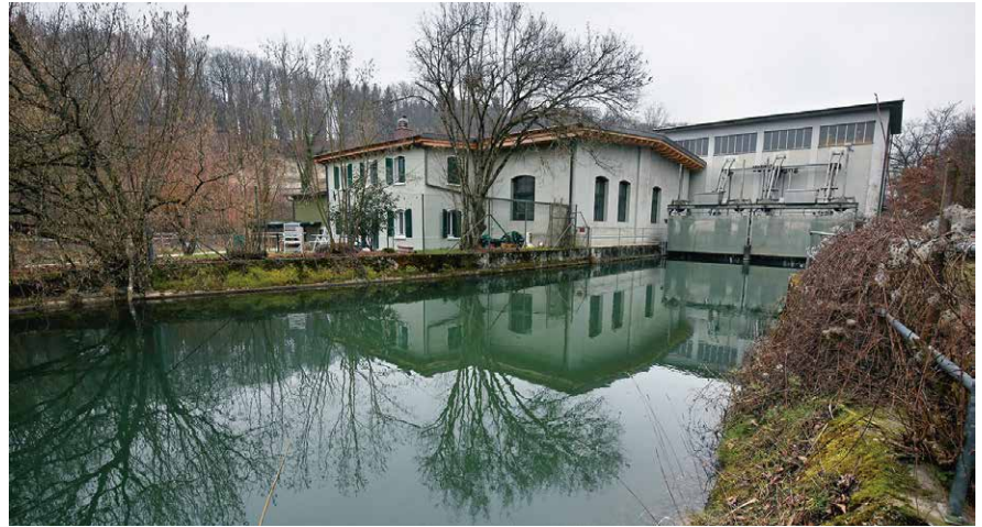
Oberwasserkanal und Kraftwerk im Bereich Altisberg. Foto: J. Ryser
