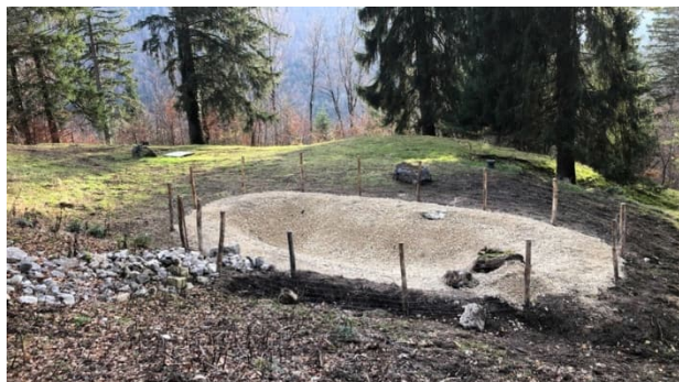
Etang en phase finale de chantier. Photo Q.Kohler, Action Lièvre & Cie Pro Natura
